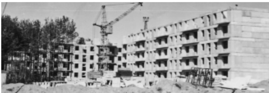
Микрорайон «Большевичка» строится.
