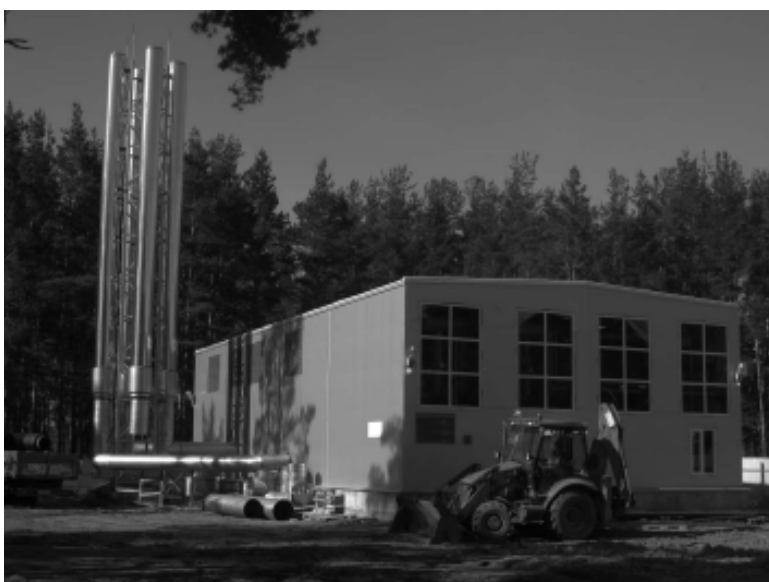
Новая модульная котельная на улице Гайдара.
