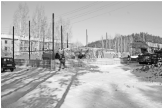
Работы по монтажу новой котельной уже ведутся на месте бывшей автостоянки напротив дома № 16 по улице Гайдара.
