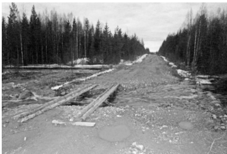
Так выглядела дорога на Колпшу в минувшие выходные... Размыло дорогу 19 апреля, днем.
