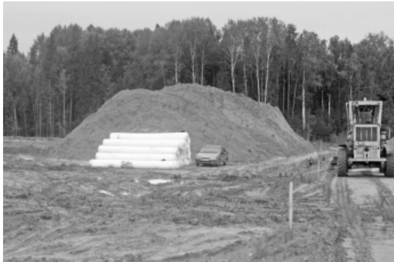
При строительстве нового полигона ТБО пришлось столкнуться с целым рядом проблем...
